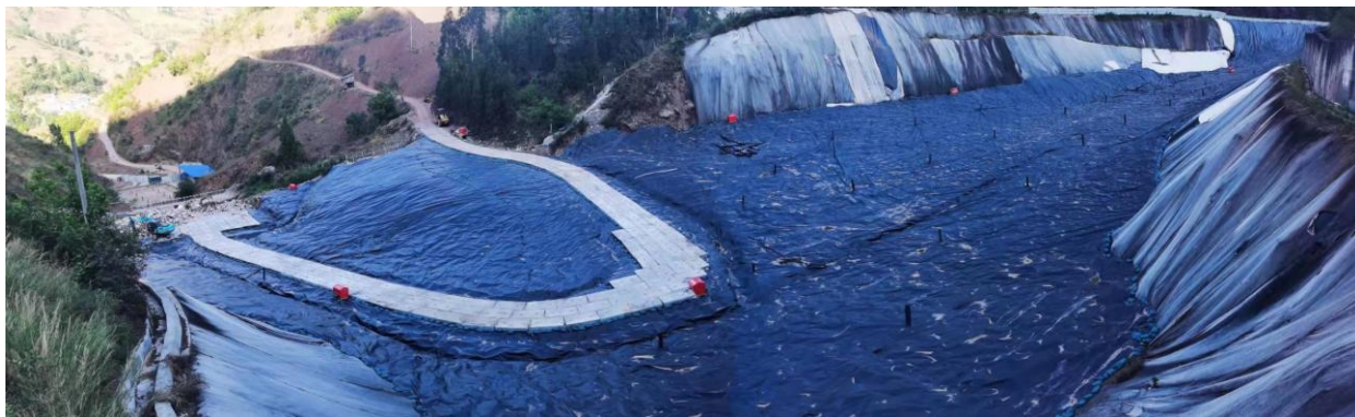
进场道路、临时道路
