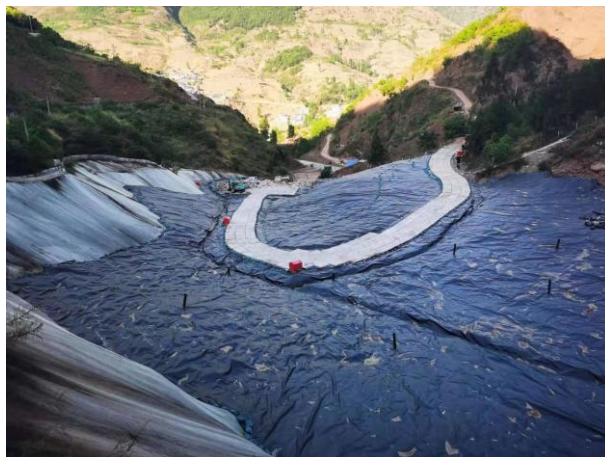
临时覆膜、雨水导流
